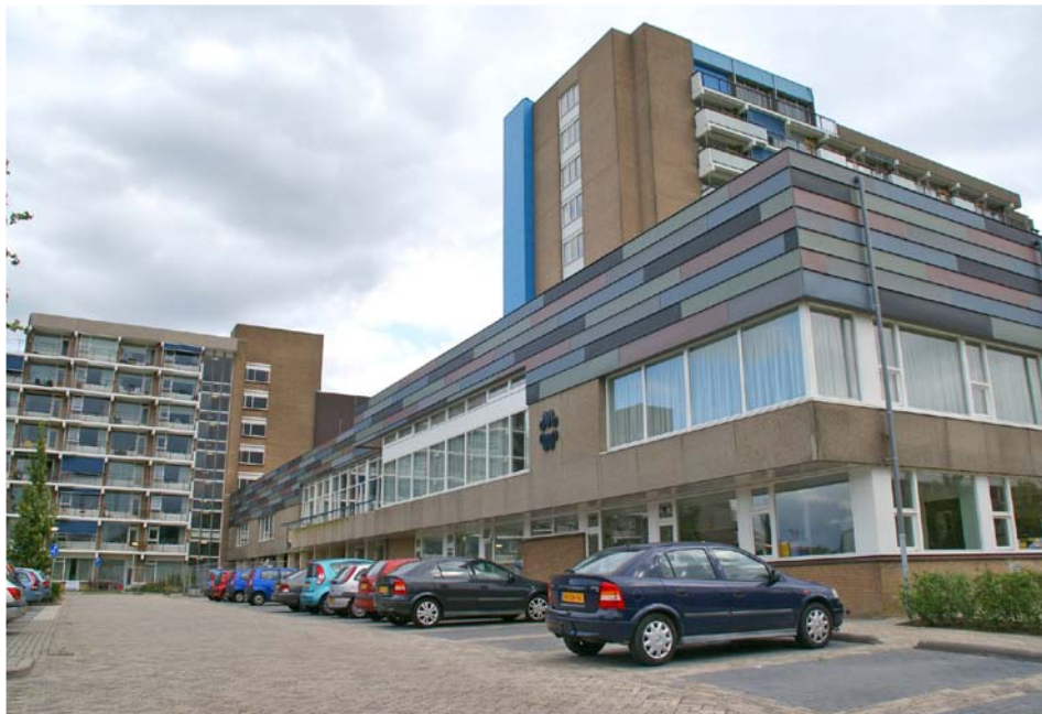
Het gerenoveerde wijk- en zorgcentrum Merwelanden
