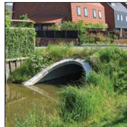
Referentie doorvaarbare duiker met afdekprofiel
